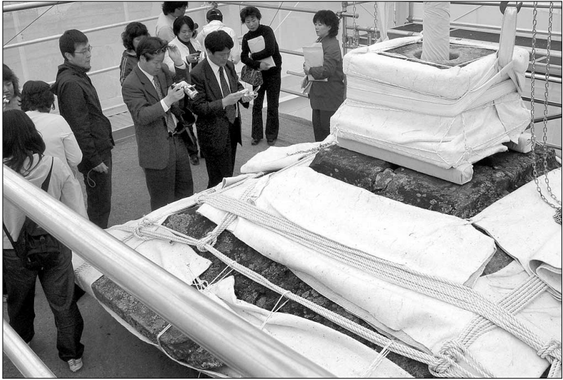
해체보수작업에 들어간 경주 감은사지 서삼층석탑은 저압외류세척으로 탑신을 깨끗이 씻은후 3D 스캐너로 형상 복원작업에 들어갔다.
