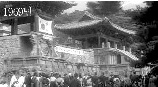
1969년 불교문화의 상징인 경주 불국사 복원 공사 기공식이 열렸다.
