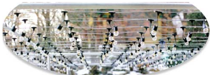
* 시공된 연등용 전선 케이블 *
