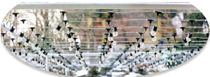
* 시공된 연등용 전선 케이블 *
