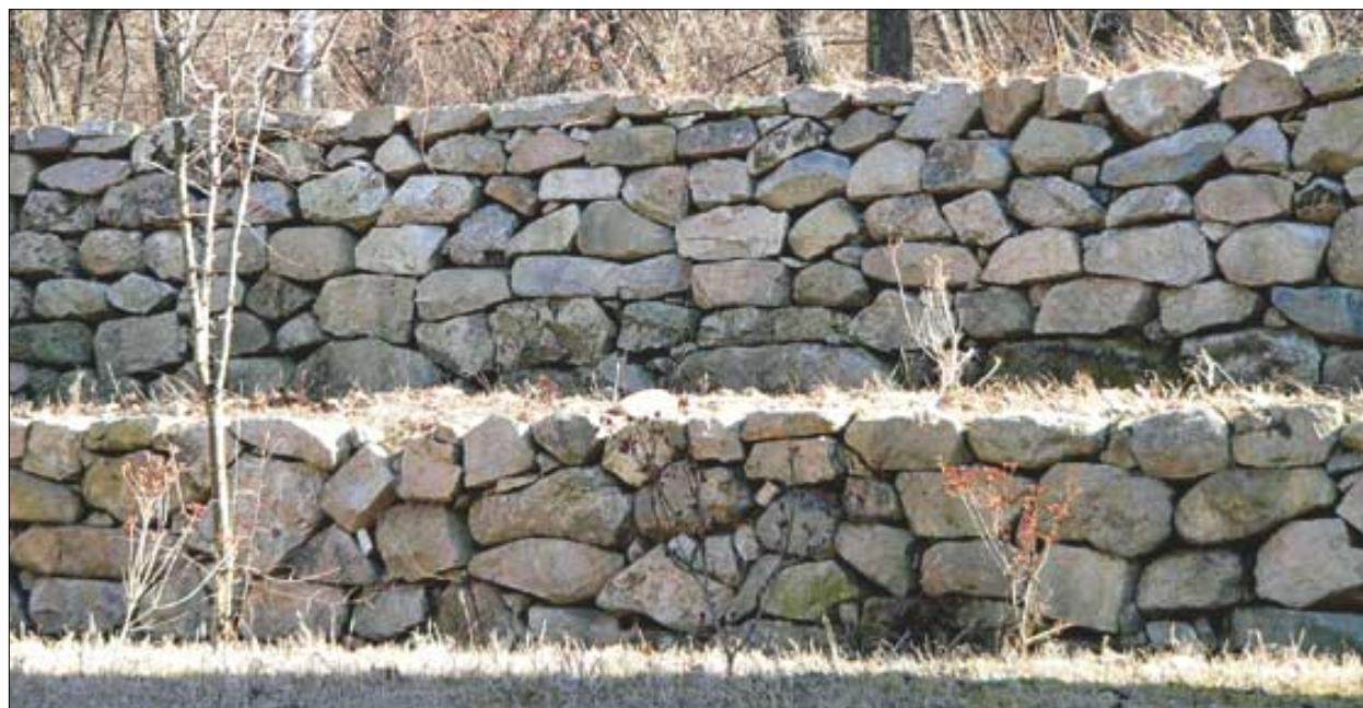
석축은 토사가 흘러내리는 것을 막아주고 산불이 전각으로 옮겨 불지 못하도록 하는 기능도 갖고 있다.
