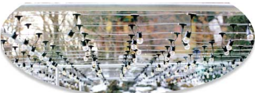
* 시공된 연등용 전선 케이블 *
