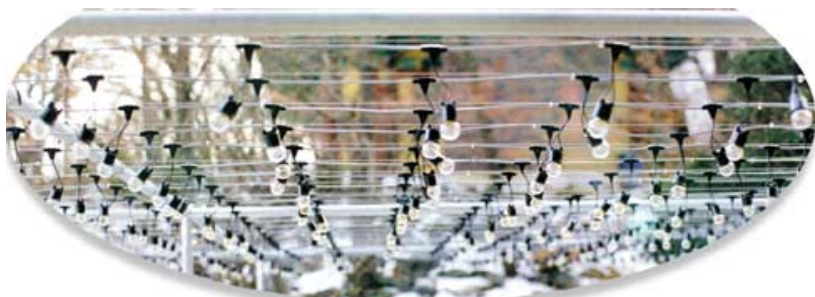
* 시공된 연등용 전선 케이블 *
