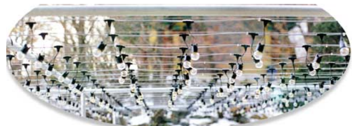
* 시공된 연등용 전선 케이블 *
