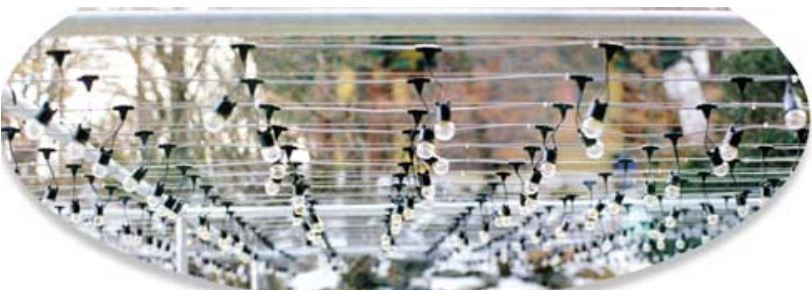
* 시공된 연등용 전선 케이블 *
