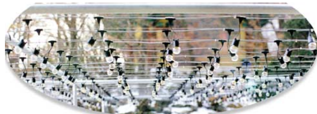
* 시공된 연등용 전선 케이블 *
