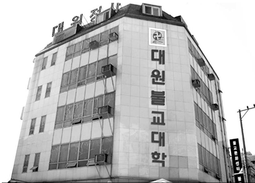
대원불교대학 건물 전경.
