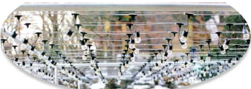
* 시공된 연등용 전선 케이블 *
