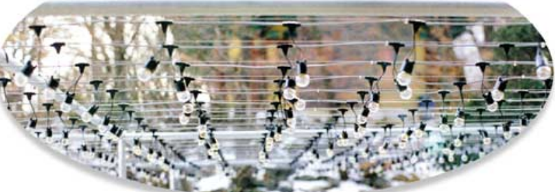
* 시공된 연등용 전선 케이블 *
