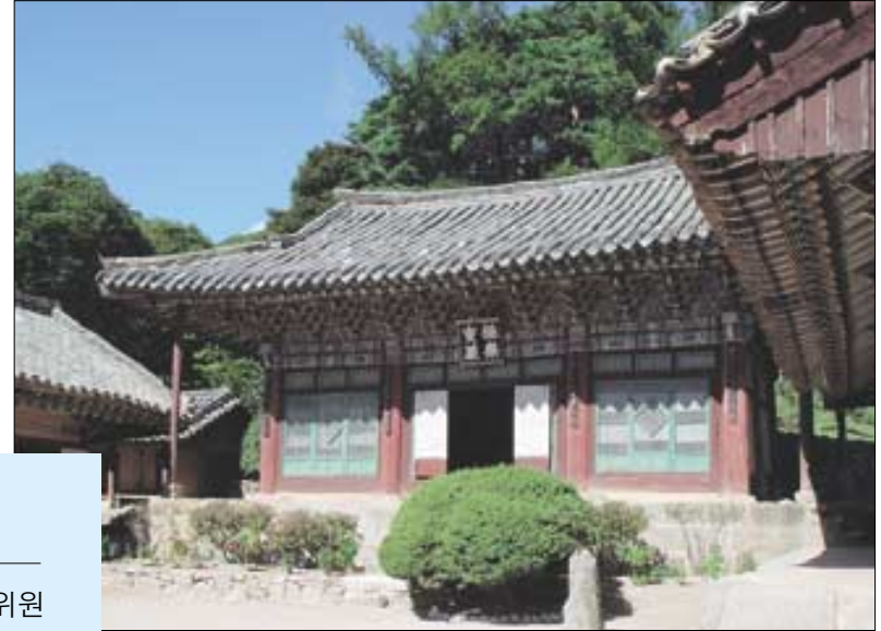
◇구월산 월정사의 전경. 정면에 보이는 건물은 극락보전.
