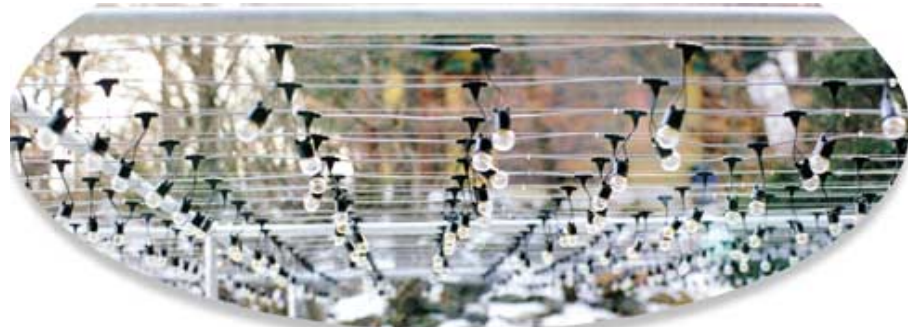
* 시공된 연등용 전선 케이블 *
