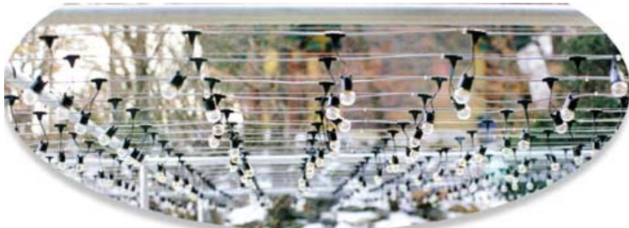
* 시공된 연등용 전선 케이블 *
