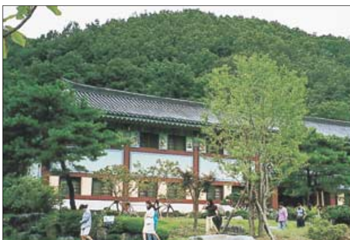
◊용인시 연화산 와우정사에 위치한 총무원건물.
