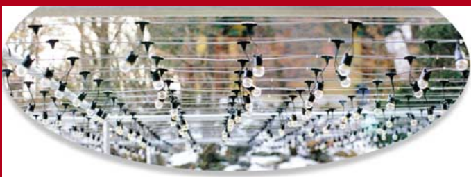
※ 시공된 연등용 전선 케이블 ※
