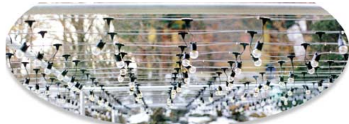
* 시공된 연등용 전선 케이블 *
