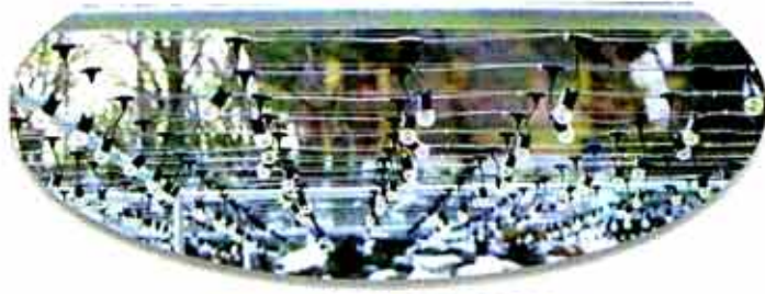
* 시공된 연등용 전선 케이블 *
