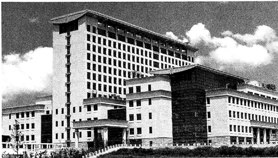
◇외관공사가 완료된 동국대 부속 불교종합병원 전경.
