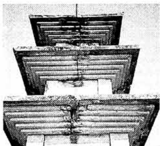
〈1층 옥개석 받침 이음새 부분이 떨어져 나간 감은사터 동탑 서쪽면 전경. (사진제공=한겨레신문)〉
