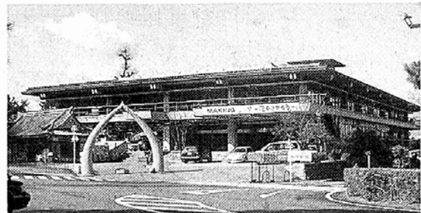
◀일본 정토종 총본산 지은원 경내에 있는 화순회관. 다목적 홀 등 호텔급 편의시설을 갖춘 회관으로 불자들에게 외국인들에게 사찰체험프로그램을 제공하고 있다.
