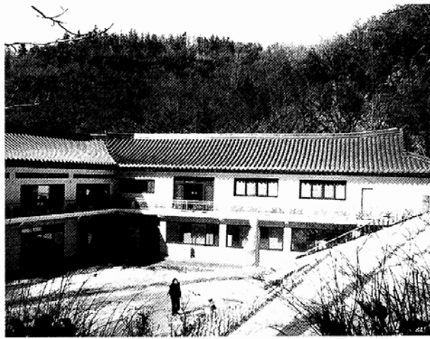
◇봉인사 한길정진원의 수련전용 공간인 자광원 전경.
