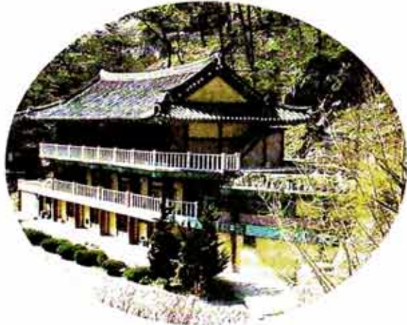
◇천축사 이후 무문관의 전통을 이은 계룡산 갑사 대자암의 '삼대당' 전경
