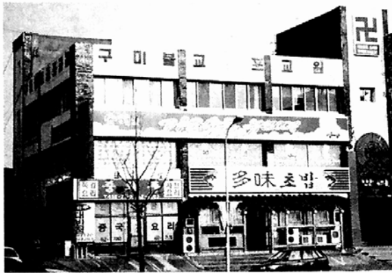
◀ 구미불교사암련회사가 오는 3월 문을 여는 첫 신도전문교육관인 구미 불교문화교육원 전경.
