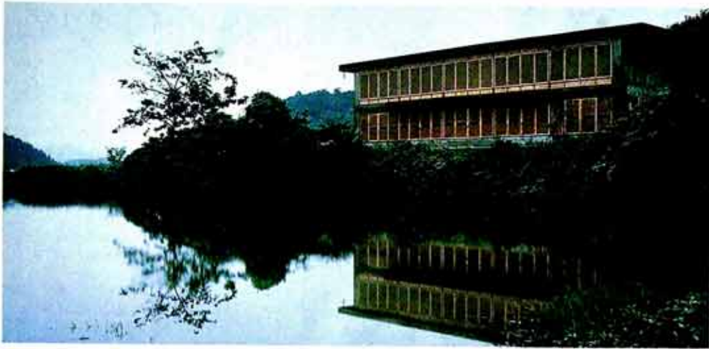
◇건축은 시대의 거울이며 시대를 담는 그릇이다. 시대가 바뀌고 사회가 변하면 건축 역시 변할 수밖에 없다. 현대가람은 굳이 '현관 기와집'을 고집할 필요는 없을 것이다. 현대가람의 새 모습을 보여주고 있는 현대건축가 김계천씨의 담양 정도사.
