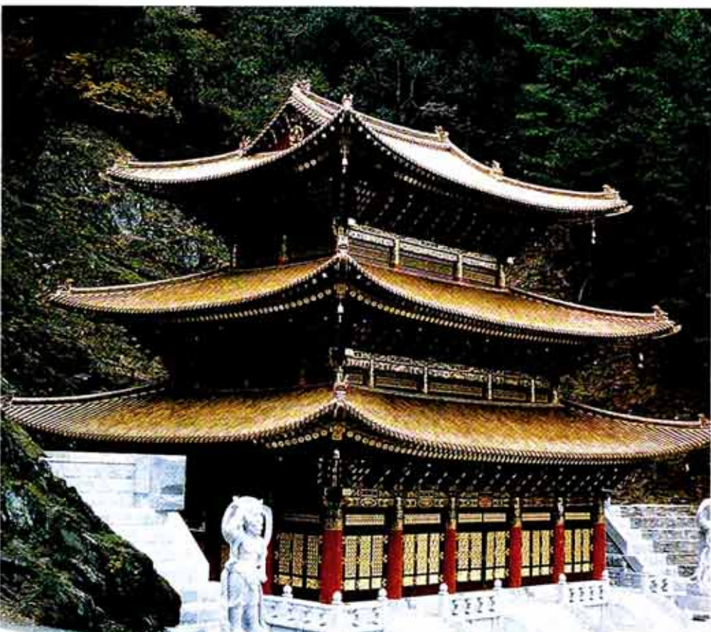
○대목장 신응수씨가 "그동안 수없이 많은 문화재 건축을 해왔지만 구인사 대조사전이야말로 생애 최고의 대표작이 될 수 있게 심혈을 기울였다"고 토로한 현대종 구인사내 대조사전, 외 7포 내 11포의 3층 다포집으로 전체를 못 하나 쓰지 않고 나무로 짜맞추었다.
