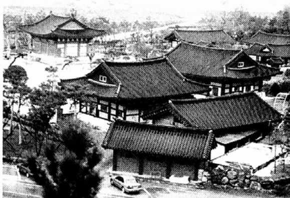
◇성철스님 열반 7년만에 수행·포교공간으로 거듭난 성철스님 생가터에 들어선 겁외사 등 건물 전경.
