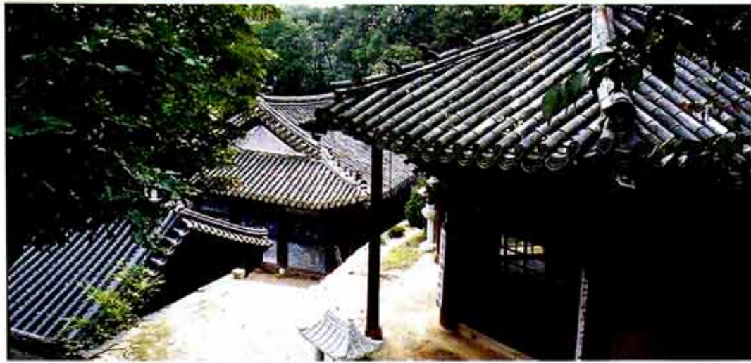
왕실의 후원을 받는 원찰로 지어진 흥국사 만월보전(사진 오른쪽 건물)은 육각형 건물로 왕실 원찰답게 빼어나고 세련된 건축 솜씨를 보여준다.
