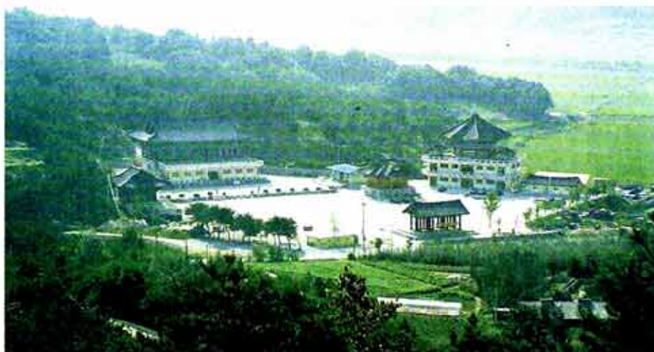
○전 관장이 사재 130여억원 들여 건립중인 한국고건축박물관 전경.
