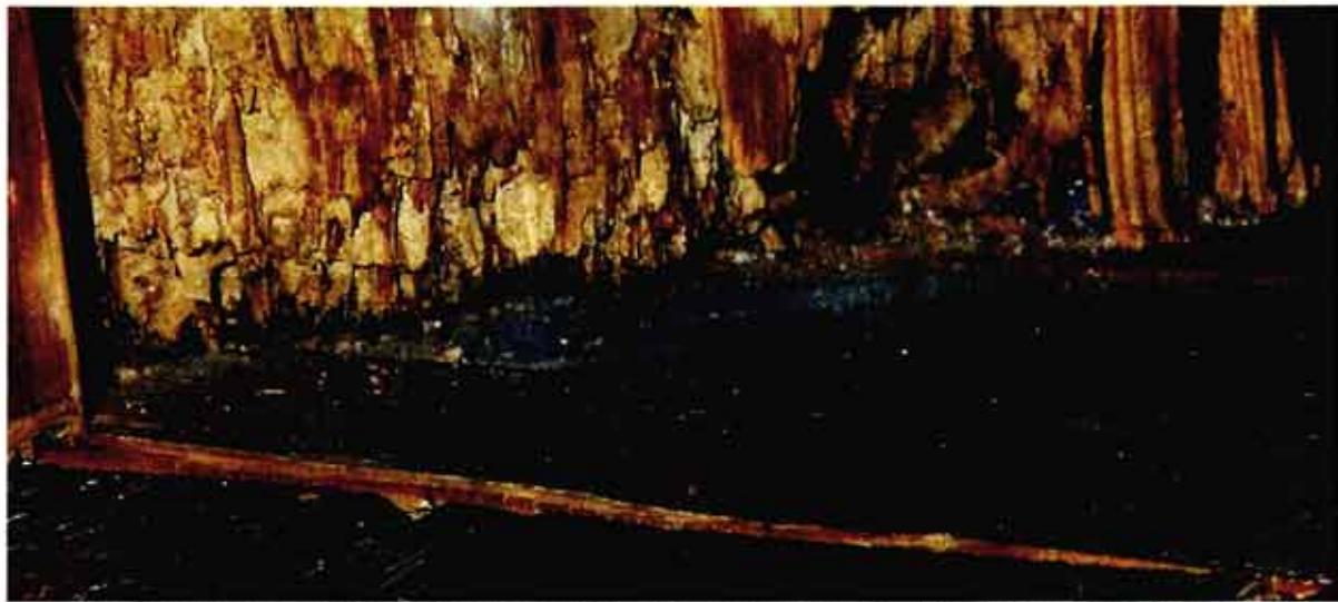
◊전북 남원 실상사 역사전. 보물 제41호인 칠채여래좌상(국보 제13호)이 봉안된 곳이지만, 흰개미 공격을 받아 정면 출입구 기둥 아래쪽이 손이 들어갈 정도로 심하게 파여있다. 흰개미는 기둥 아래에서 위로 이동, 결국 서까래와 지붕까지도 공격한다는게 전문가들의 지적.
