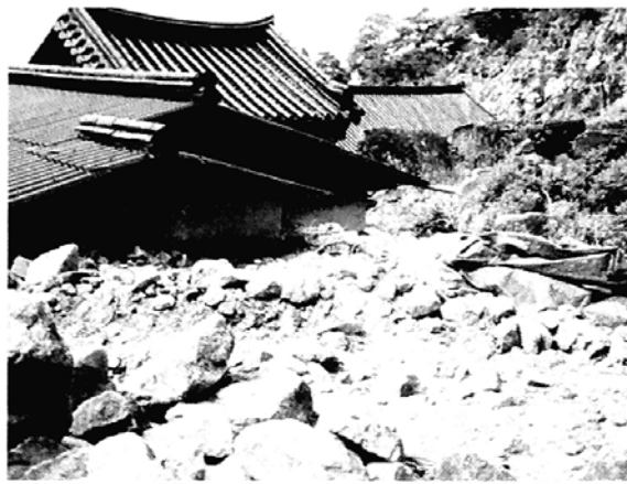
○산사태로 물과 토사가 밀려와 산신각 아래쪽 요사채가 매몰된 문경 윤필암 선원 법안까지 물이 차고 주차장과 축대가 붕괴되는 등 큰 피해를 입었다
