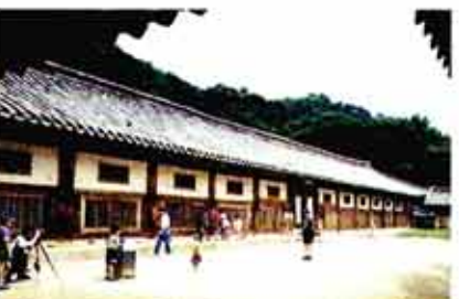
○해인사 장경각은 수나라장·법보전·동서간고 등 4동으로 이루어졌다. 그중 수나라장은 넓은 서까래와 긴 처마(차레)를 갖춘 출세마집의 우주건축물로 내부의 경관을 보호하고자 동풍과 온도 등을 고려하여 건물 외벽에 돌박이 상감을 두었다.
