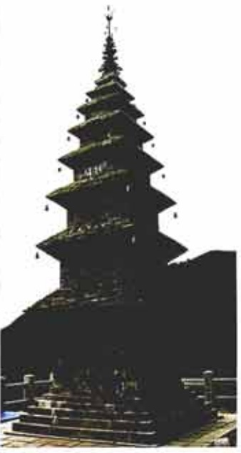
정암사 수마노탑 전경.
