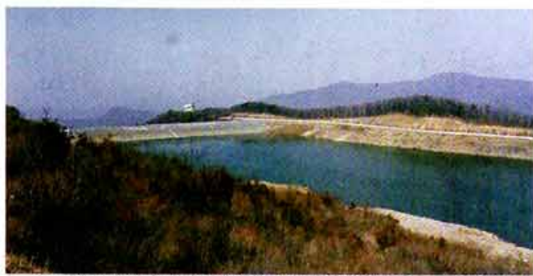
◇해발 950m 지점에 건설된 양수발전소 이곳이 안국사와 적상산 史庫 터다. 현재의 안국사는 1949년 여순사건으로 인해 소실된 호국사터로 옮겨지었다.
