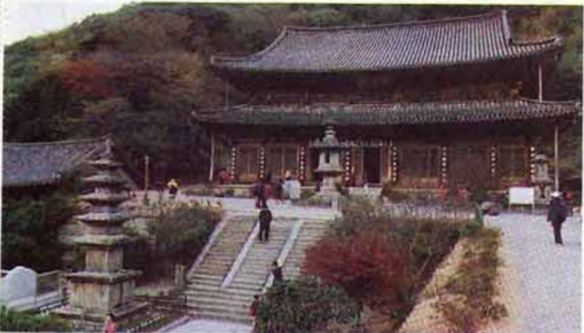
◀ 현존하는 우리나라 불전 가운데 가장 규모가 큰 화엄사 각황전(국보 제67호). 그 앞의 석등(국보 제12호) 역시 우리나라 석등중 가장 크며 각황전과 짝을 이뤄 담당한 위엄을 느끼게 한다.
