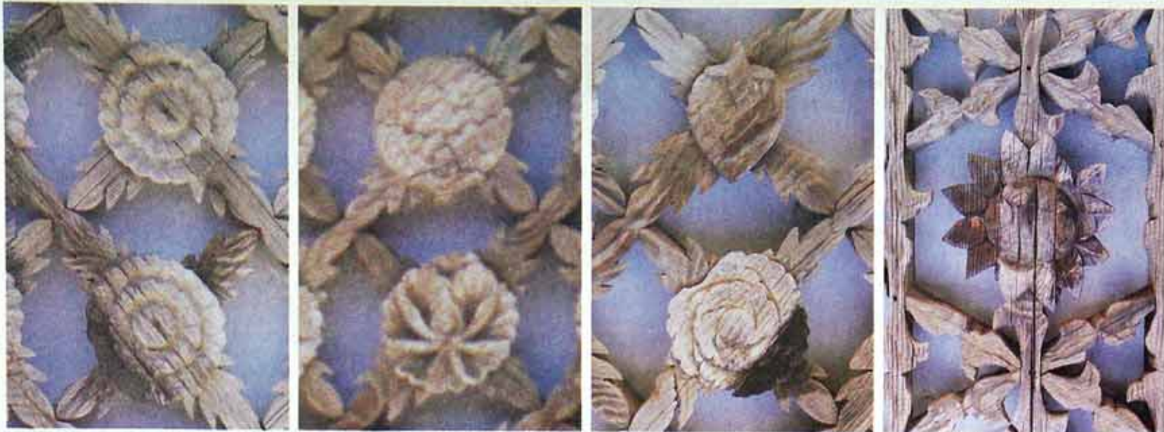
◇방금 피어나 은은한 향을 내뿜는듯 하는 내소사 대웅보전의 꽃창살문. 우리나라 대웅전문 가운데 으뜸으로 꼽힌다(왼쪽부터 빗꽃화살문, 빗면모란꽃문, 빗모란꽃문, 소솔연꽃문).
