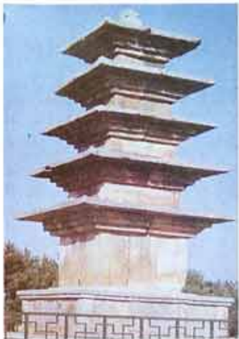
익산왕궁리오층석탑 고려초기 제작된 것으로 추정되는 작품으로 옥개(屋蓋) 양식은 백제석탑을 따르고, 탑신부의 결구(結構)와 옥개받침 수법은 신라석탑을 따르고 있다.
