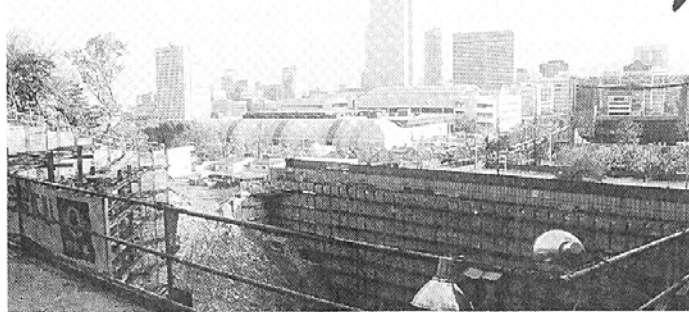
◇서울 봉은사기 건립중인 봉은문화회관이 이미 골토공사를 마쳤으나 공사비과다 증액, 설계변경등의 의혹이 있어 조계종 중앙종회가 사업승인 취소를 결의, 사업의 전면 재검토가 불가피하다.
