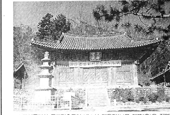
◇조선중기의 목조건축물인 내소사 대웅전(보물 제291호)은 정면 3칸, 측면 3칸의 방형건물로 정면 3칸은 모두 정교하게 소슬못살청호를 닦았다.
