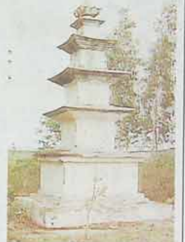
▶ 베트남 전쟁 당시 백마부대 주둔지 안에 조성된 백마사의 시멘트 탑. 흉탄흔적이 선연하다.
