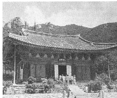
▷원효와 의상이 머물렀다는 전록 부인 변산기슭에 자리잡고 있는 개암사. 정면 3칸 측면 3칸의 팔작지붕 건물인 대웅전은 조선전기 대표적 건축물로 꼽힌다.
